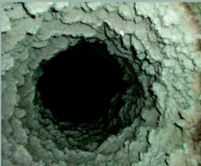
Brian Steffensen og hans makker i AVS Henrik Brogaard, har set mange ventilationssystemer, hvor støvet havde sat sig i et tykt lag på indersiden. Et så stoppet system duer overhovedet ikke.
